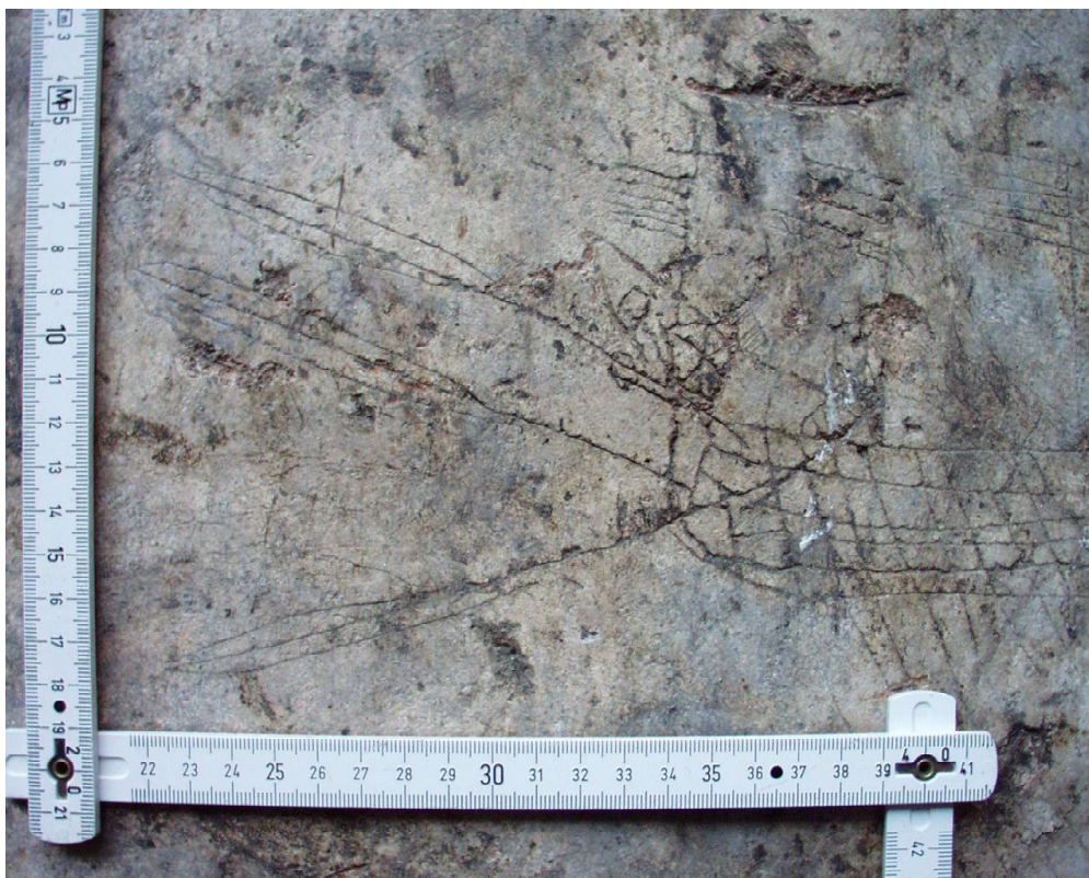
Foto 7. Jednorzędowiec z żalagą - ściana północno-wschodnia
